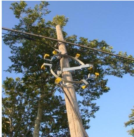
Figura 7 – Esempio sistema di fissaggio per scorta aerea
